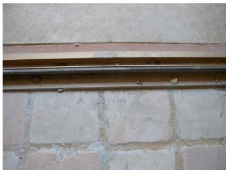
Connessione rigida in corrispondenza della portafinestra
