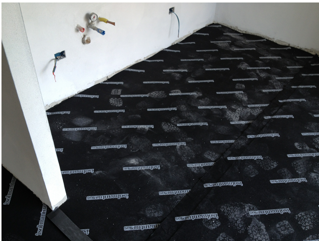
Isolamento muratura perimetrale e pavimento.
